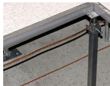
Hình 4. Hệ thống nối đất
